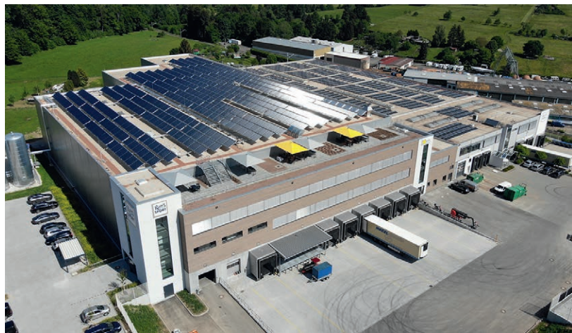
Auf dem Dach des Roh- und Packstofflagers von Ritter Sport in Dettenhausen ist Deutschlands größte Solarthermie-Dachanlage installiert (links im Bild) und daneben eine Photovoltaikanlage mit 462 Kilowatt Leistung. Unter anderem für die Elektro-Lkw betreibt das Unternehmen zwei Stromspeicher à 150 Kilowattstunden Kapazität.
