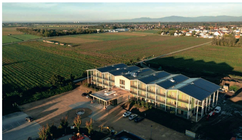
Landhotel und Maschinenhalle des Bohrerhofs nutzen eine 390-Kilowatt-Photovoltaikanlage und einen 200-Kilowattstunden-Batteriespeicher.
