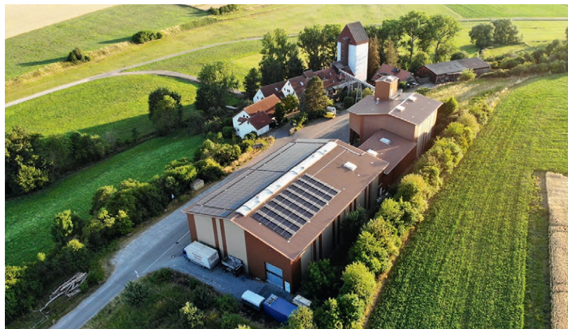
Die Altdorfer Mühle betreibt seit 2021 eine 99-Kilowatt-Photovoltaikanlage und einen Stromspeicher mit 70 Kilowattstunden Speicherkapazität.
